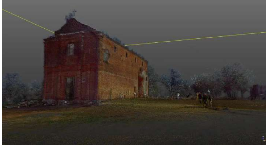
Figure 2. Point cloud of the Calera de las Huérfanas.
