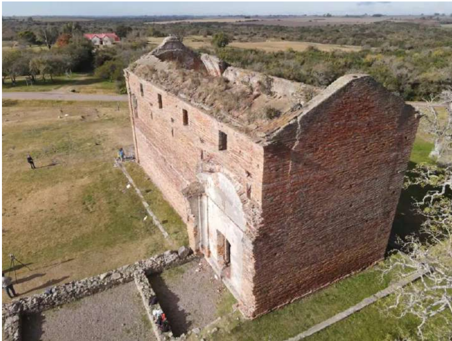
Figure 1. Calera de las Huérfanas. Aerial drone shot.
