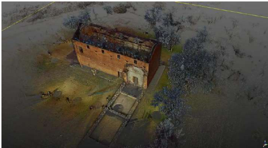
Figure 3. Point cloud of the Calera de las Huérfanas.
